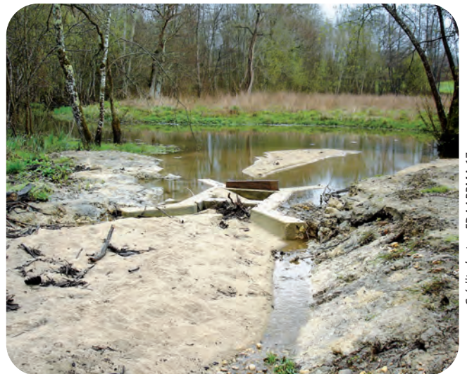
Ensablement de l'ouvrage de St-Palais-de-Négrignac en Charente-Maritime (17).
