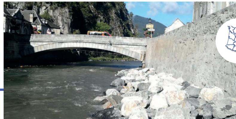
En rive droite, le procédé ne fut pas le même, il s'agissait d'injecter du béton en pied de mur, il a donc été intégré des blocs de pierre dépassant de ce socle, sur lequel d'autres enrochements non jointifs ont été déposés, permettant ainsi, tout en protégeant le mur, créer des nombreuses caches dans les interstices de ces rochers.
